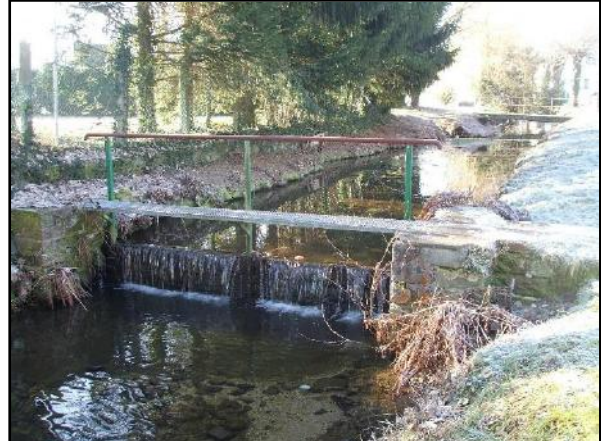
Seuil sur ruisseau 1 permettant d'alimenter les serres de Cocagne
