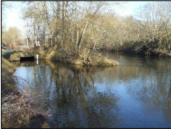
Ruisseau R3 : prise d'eau sur canal BTT (1,5m 3 /s ; arrêté préfectoral n°263/94)
