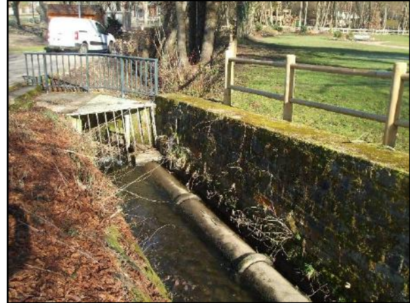
Prise d'eau VNF sur ruisseau R3 (débit réservé : 0.15m 3 /s ; arrêté préfectoral n°263/94)
