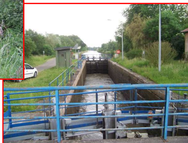
Photo10 – Ecluse aval zone d'étude
