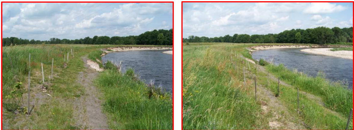
Photo 12 – Erosion berge rive gauche
