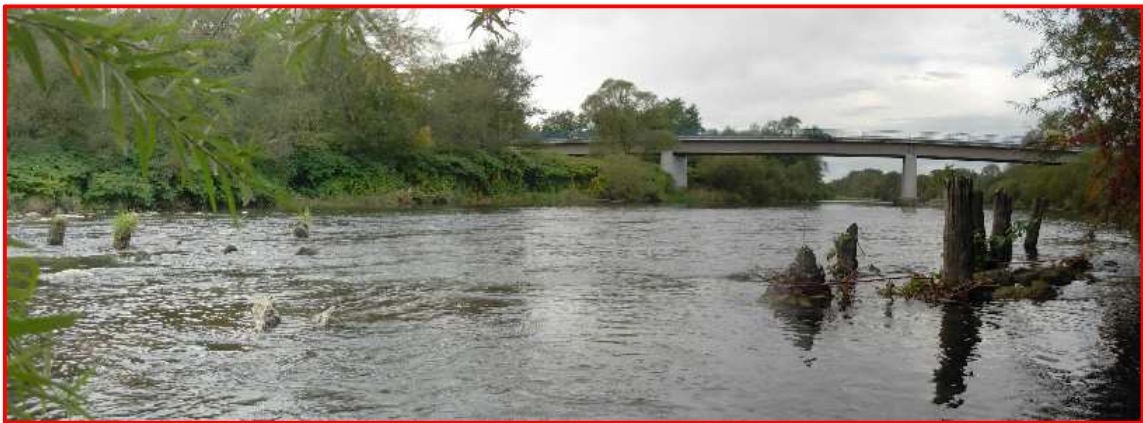
Photo 1 – Pont de la RD62 et vieux seuil aval
